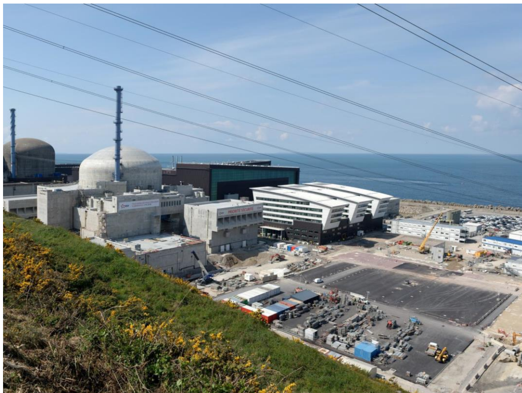
Rys.2. Widok na plac budowy Flamanville 3 (kwiecień 2017); źródło EDF
